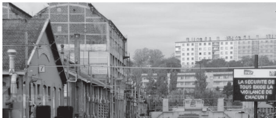
Le Technicentre plein d'amiante.
