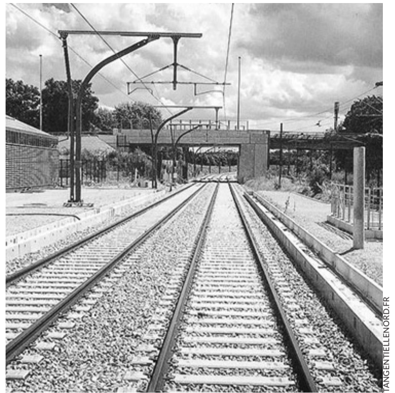
Les voies de la future ligne T9.
