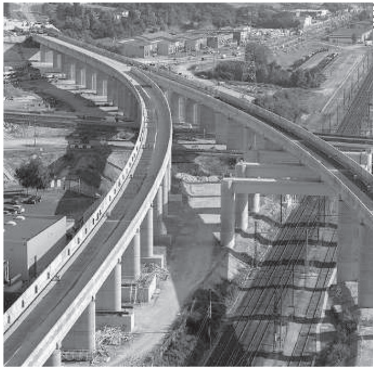
Un ouvrage d'art de la LGV Tours Bordeaux.
