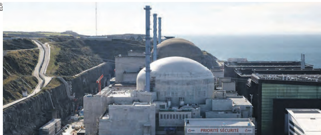
La centrale de Flamanville et l'EPR en construction.
