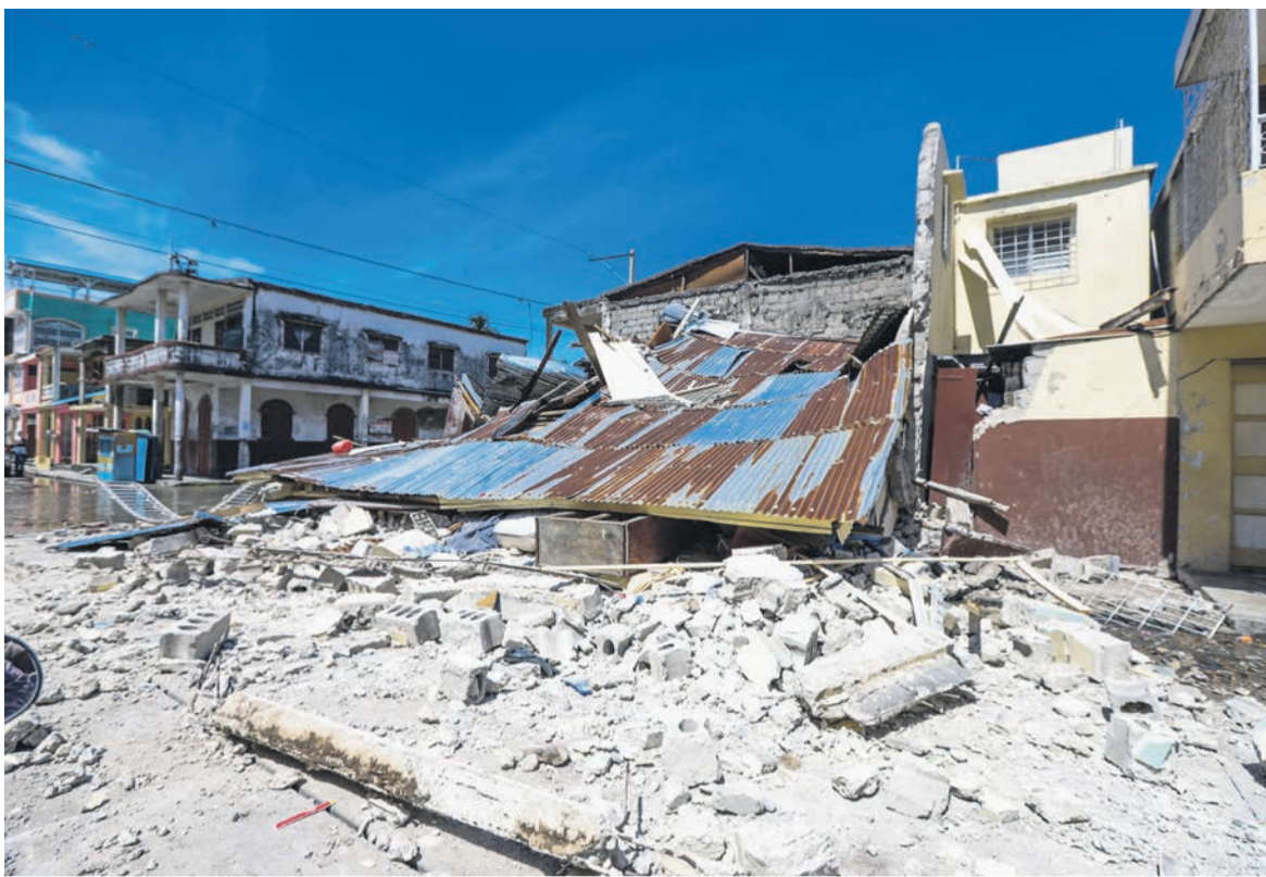
Les ravages du séisme du 14 août 2021.
