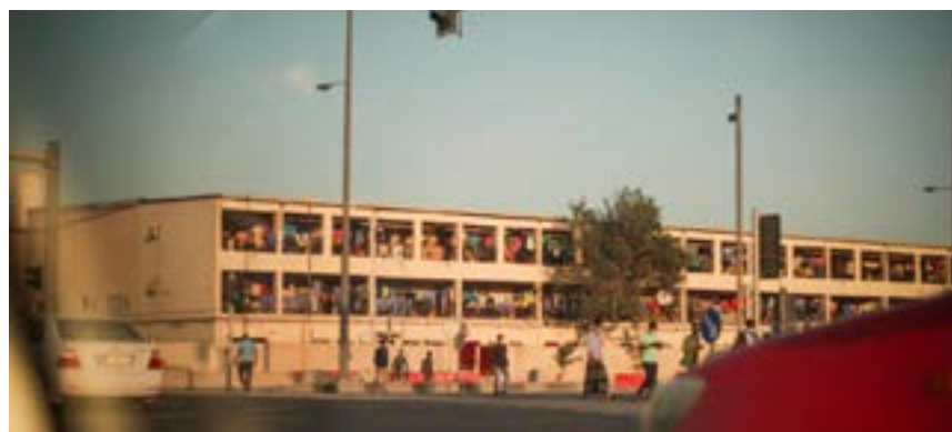
Logements ouvriers photographiés clandestinement.
