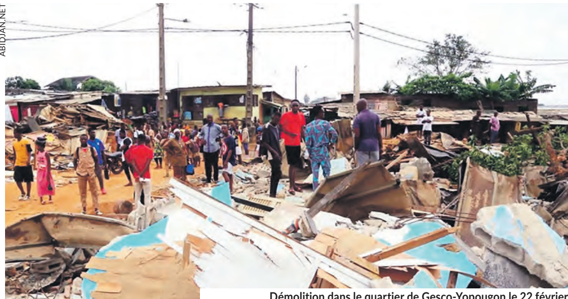
Démolition dans le quartier de Gesco-Yopougon le 22 février.
