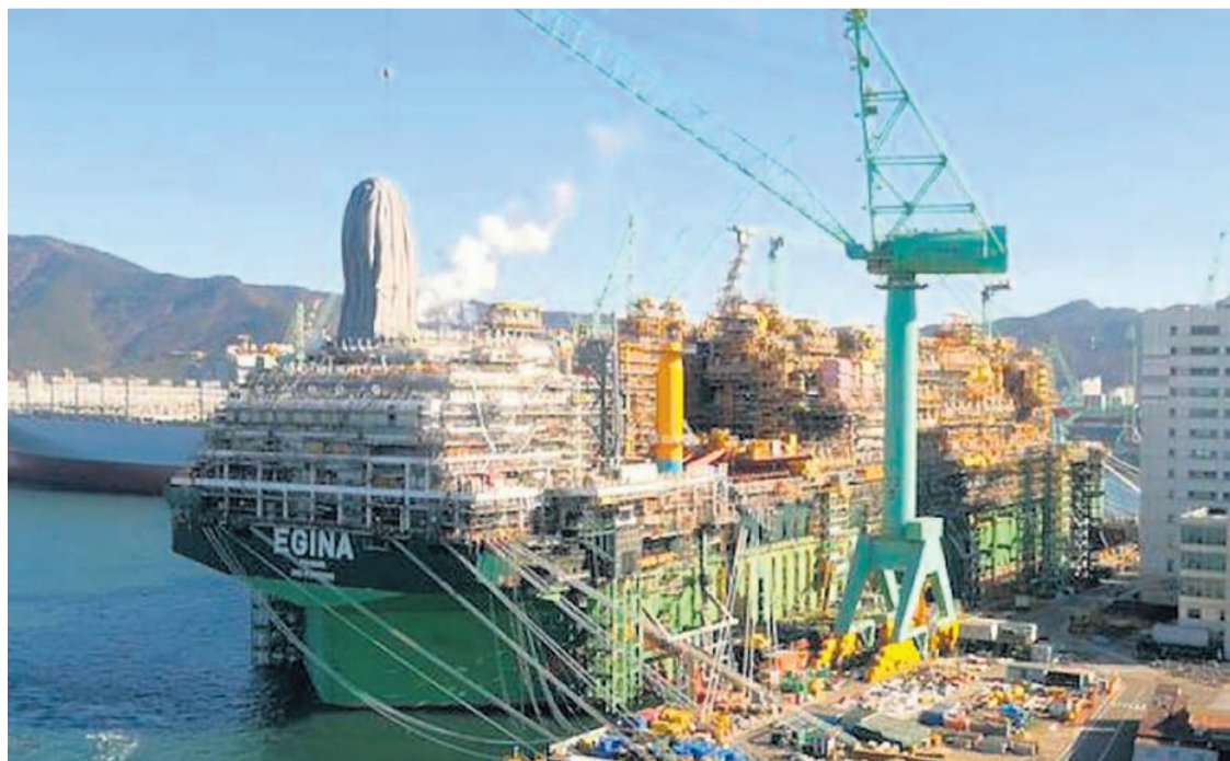
Plateforme pétrolière Egina en construction destinée au Nigeria.
