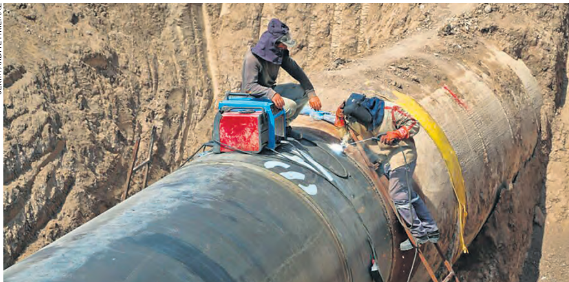
Gazoduc en construction au Mozambique, en novembre 2024.
