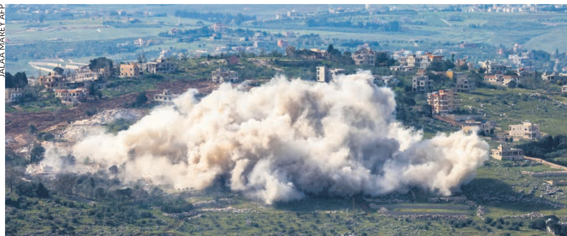
Destruction d'immeubles et de maisons dans le sud du Liban, le 27 avril.
