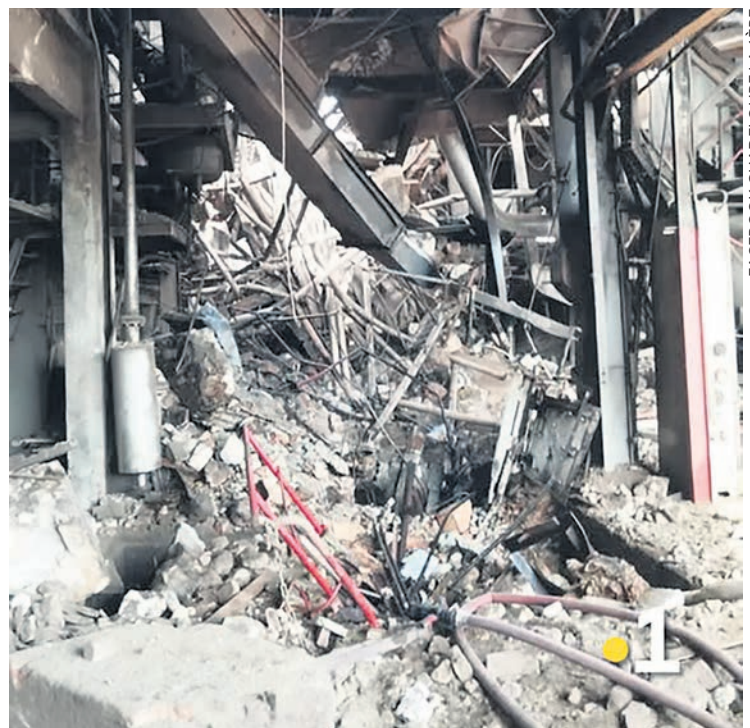
Explosion de la chaudière de la distillerie
